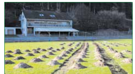
Mit der Sanierung des Stadions zum Ausbau einer modernen Sportstätte wurde bereits Ende 2020 begonnen.
